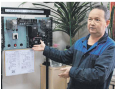
Замначальника ЦТАИ Александр Лидер демонстрирует обучающий стенд
